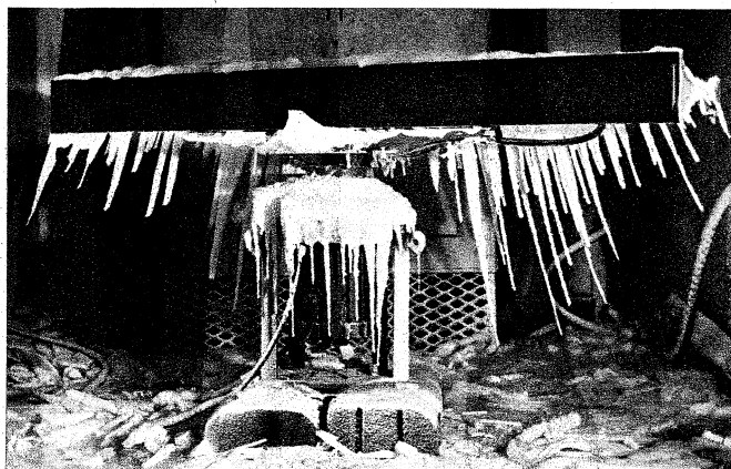
Bild 2. Nach dem Einblasen von Preßluft dehnt sich ein über die Schlitzantenne gezogener Kunststoff aus und sprengt das Eis ab. Die Vorderfront der Radarantenne ist vollkommen eisfrei
